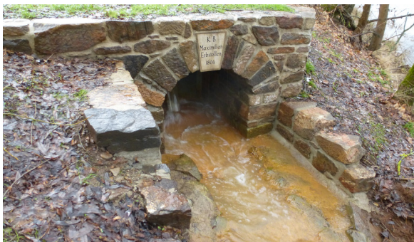
Stollenmundloch an der Haßlach
